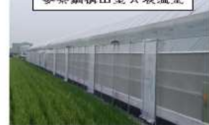
麥寮鋼構山型 A 展溫室
