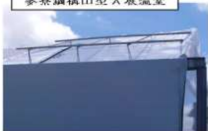
麥寮鋼構山型 A 展溫室
